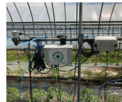
ハウス内環境計測:みどりクラウド
