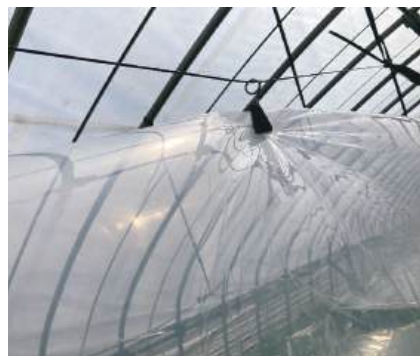
ポリダクト取付部分
